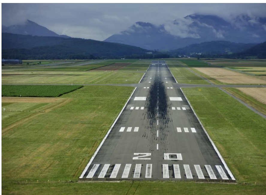
Рисунок 14 – Характерное пятно первых контактов пневматиками шасси поверхности взлетно-посадочной полосы.
